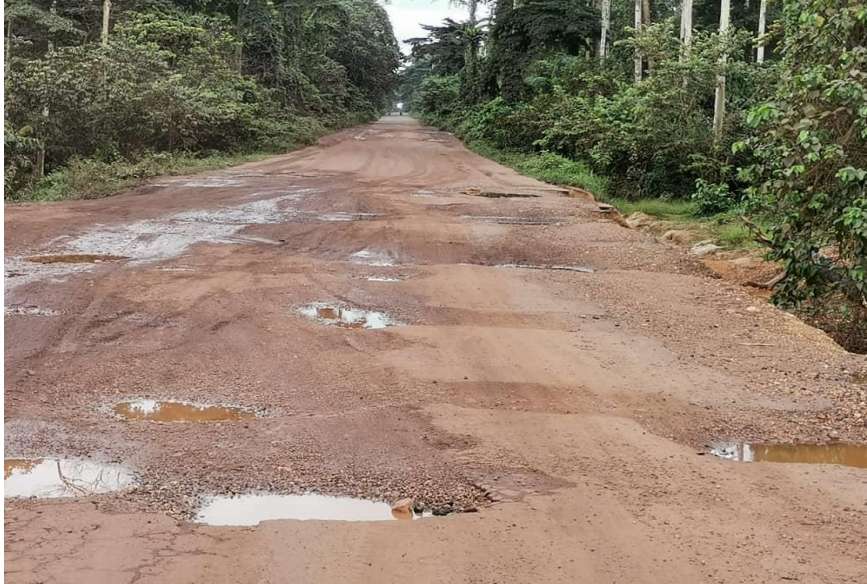
Figure 1 : Routes à base de sol latéritique dégradées sur la côte du Sud de la Côte d'Ivoire
