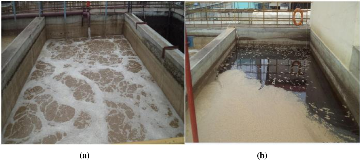
Figure 20 : Bassins aérobies en phase d'alimentation et d'aération (a) et en phase de décantation (b)
