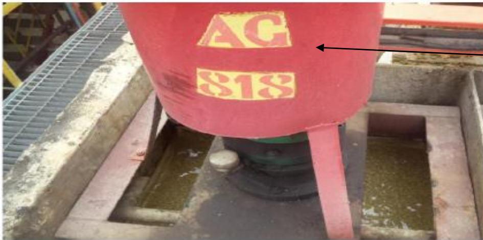
Figure 18 : Injection de flocculant suivie d'une agitation rapide
