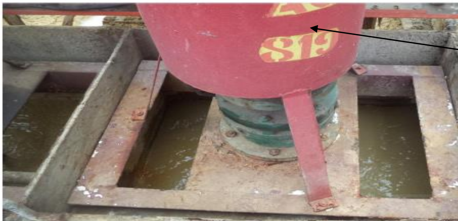
Figure 17 : Injection de coagulant suivie d'une agitation rapide
